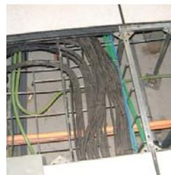
A instalação de uma tubagem de recolha de amostras VESDA num chão falso e junto a cablagem de alto risco, permite a detecção precoce de fumo nessa área.
